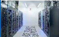
Eigenes Rack, entweder im Carrier-Meet-Me-Room (CMMR) oder auf der Colocation-Fläche. Colocation Racks von 3 bis 20 kW für Umgebungen mit hoher Leistungsdichte.
